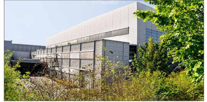
Hinter diesen Wänden befinden sich 4 der circa 15 Meter hohen und 15 Meter langen Druckmaschinen, die die Saftpresse aufs Papier bringen.
